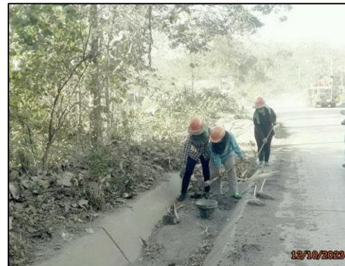
รูปที่ 2-28 การขุดลอกตะกอนดินในคูระบายน้ำ ของโครงการ
