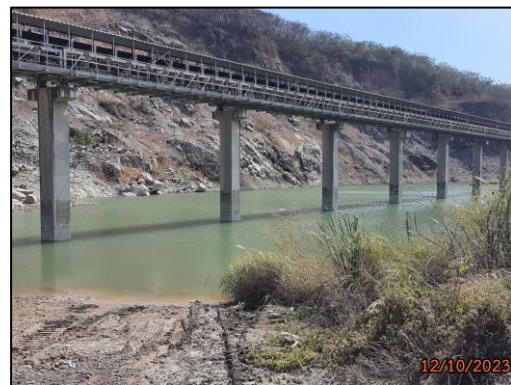
รูปที่ 2-8 บ่อรวบรวมน้ำ (Sump) บริเวณจุดต่ำสุดของ หน้าเหมืองในแต่ละช่วงการทำเหมือง
